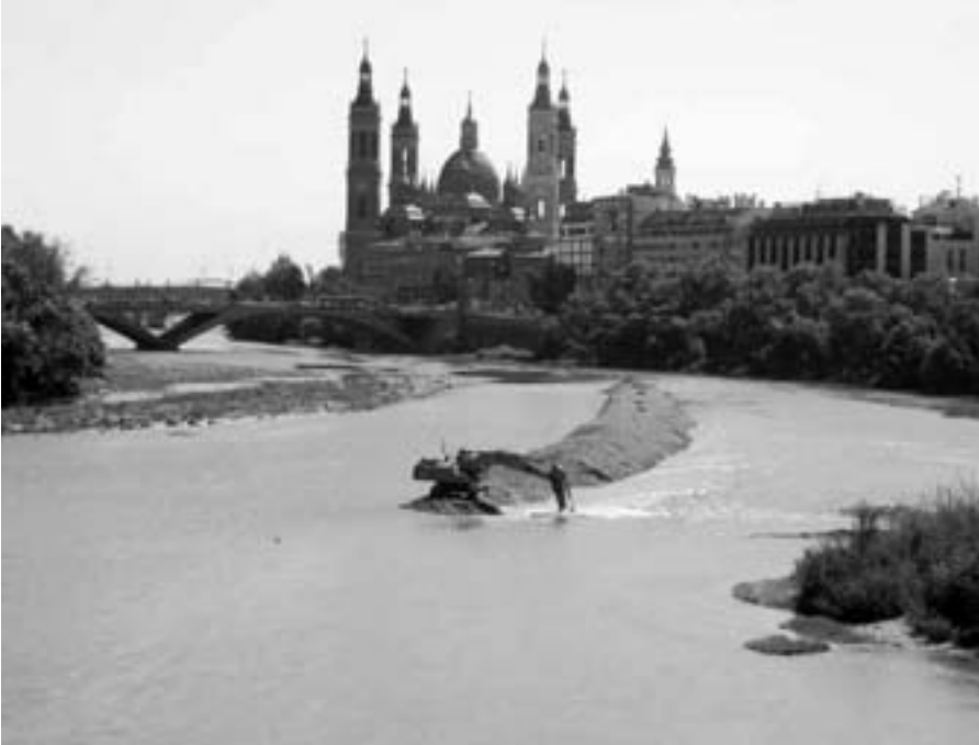
Foto 6. Los dragados alteran la geomorfología del fondo del cauce, incrementan los riesgos y necesitan un costoso mantenimiento, ya que el río los modifica en cada crecida. Este caso corresponde a la apertura de un canal de navegación para la Expo Zaragoza 2008.
