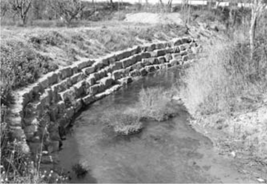
Foto 5. La escollera es la gran invasora del paisaje fluvial en las últimas décadas, impidiendo la dinámica de los ríos meandrizantes. Río Huerva en Cuarte (Zaragoza).
