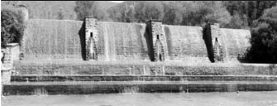
Foto 3. Presa de Isín (río Aurín, afluente del Gállego). Los impactos de presas y embalses son muy negativos. Muchas presas pirenaicas, como la de la imagen, se construyeron para retener sedimentos y están ya colmatadas. Para restaurar el río habría que demolerlas.
