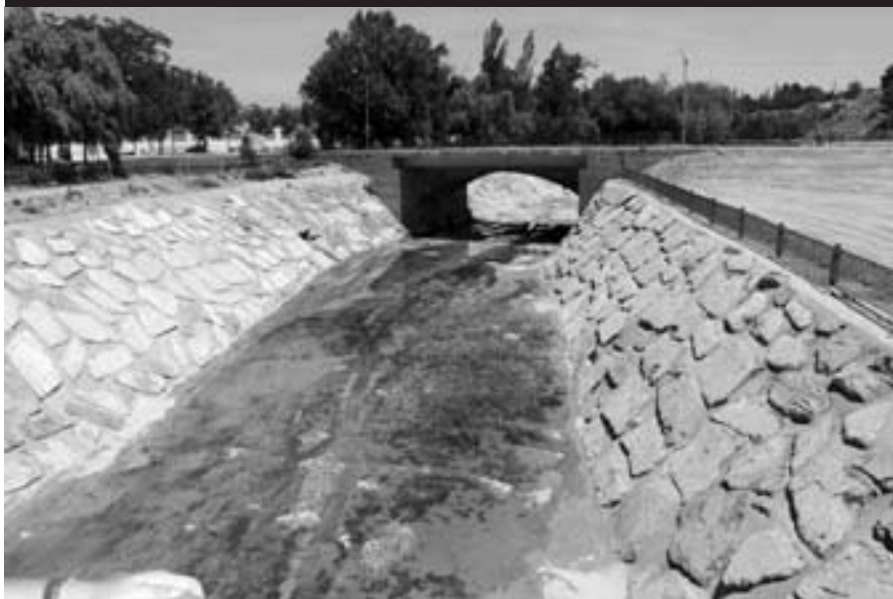
Foto 9. Canalización urbana del río Arba de Biel en Ejea de los Caballeros para instalar un "parque fluvial" en las orillas. El río ha perdido toda su naturalidad.
