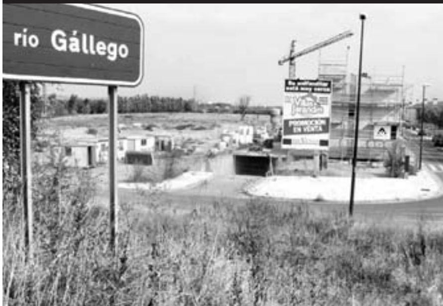
Foto 4. Invasión de la llanura de inundación por urbanizaciones recientes (Santa Isabel, Zaragoza), añadiendo un elemento de riesgo sin precaución alguna, ya que se construye con planta sótano.
