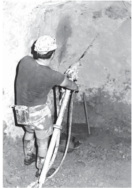
Barrenista abriendo el barreno en el frente de estéril con el martillo perforador. (Archivo CELAN)
