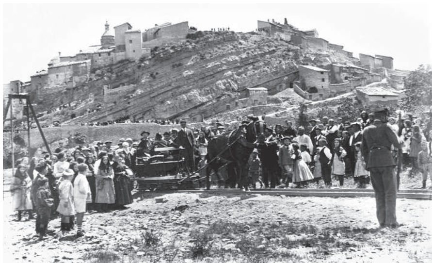
Inauguración por las autoridades, civil y eclesiástica, del “tranvía” tirado por caballos que iba de Oliete a las obras del pantano de la Foradada. Esa misma vía serviría para subir y bajar materiales para la obra en construcción. (Foto del archivo familiar del autor)
