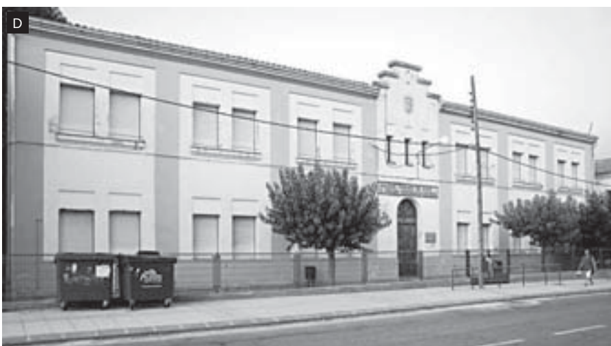
A. Casas, calvario y huertos vistos desde la iglesia. B. Ermita de San Blas. C. Calle Carralafuente. D. Escuela pública construida en la II República. (Fotos JAP)
