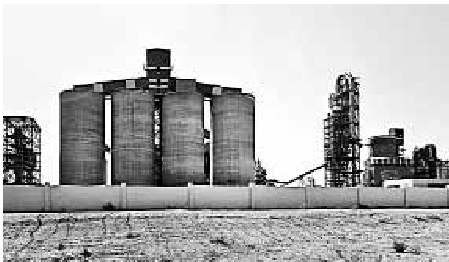
Vista de la fábrica de cementos de Andorra, en la actualidad, construcción parada. (Foto Antonio Pizarro)
