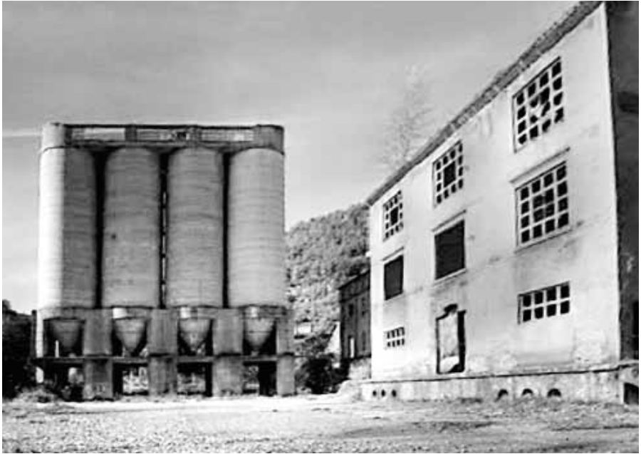
Restos industriales de la fábrica de cemento de Xerallo (Lérida), explotada por ENHER
