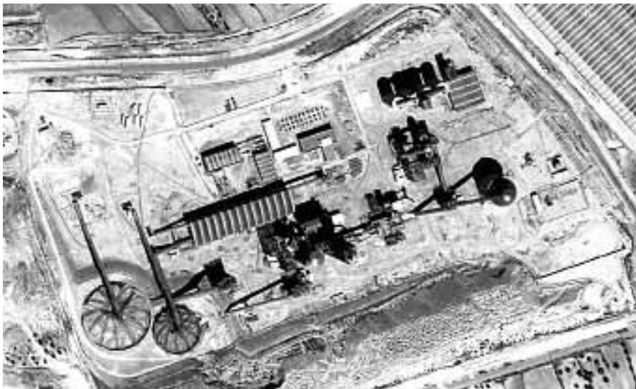
Vista aérea actual de la fábrica de cemento de Andorra
