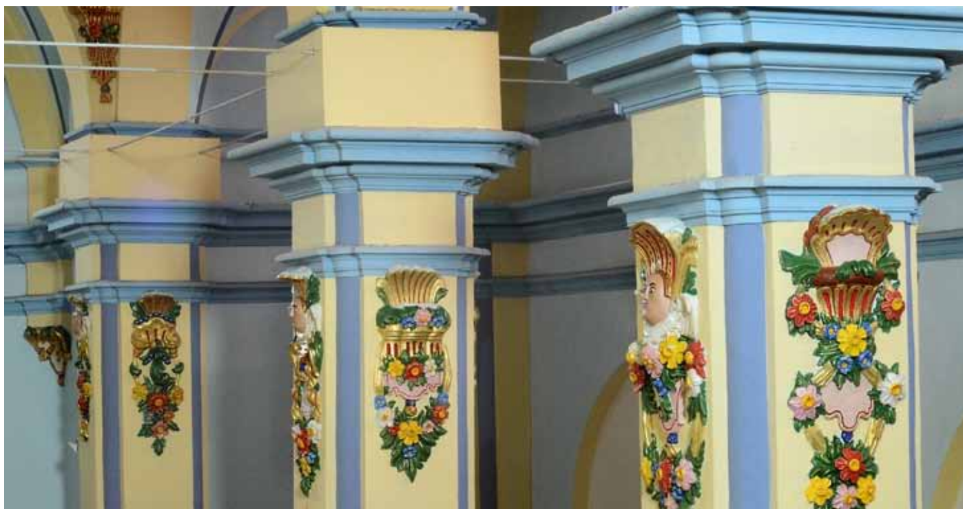
Detalle de la ornamentación de los muros
