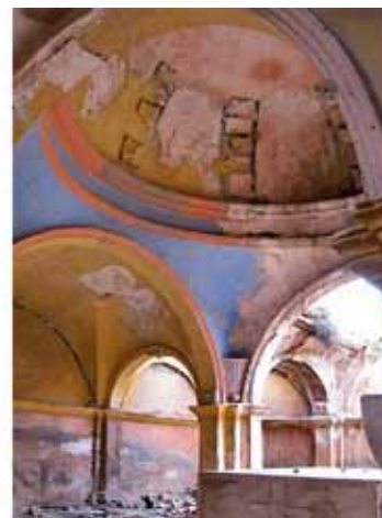
2.- Estado inicial de la ermita
