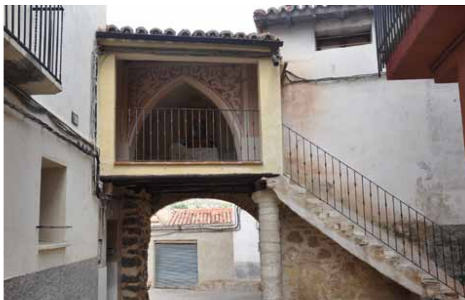
El portal de la Barrera y la capilla de los Santos Mártires antes y después de la restauración.
