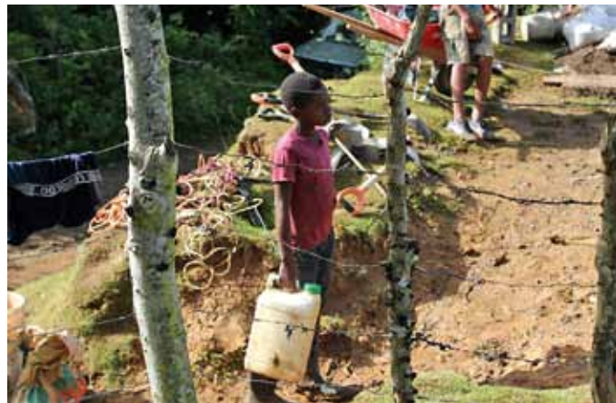
Niño ayudando en la construcción de una casa en Las Claras, República Dominicana.
