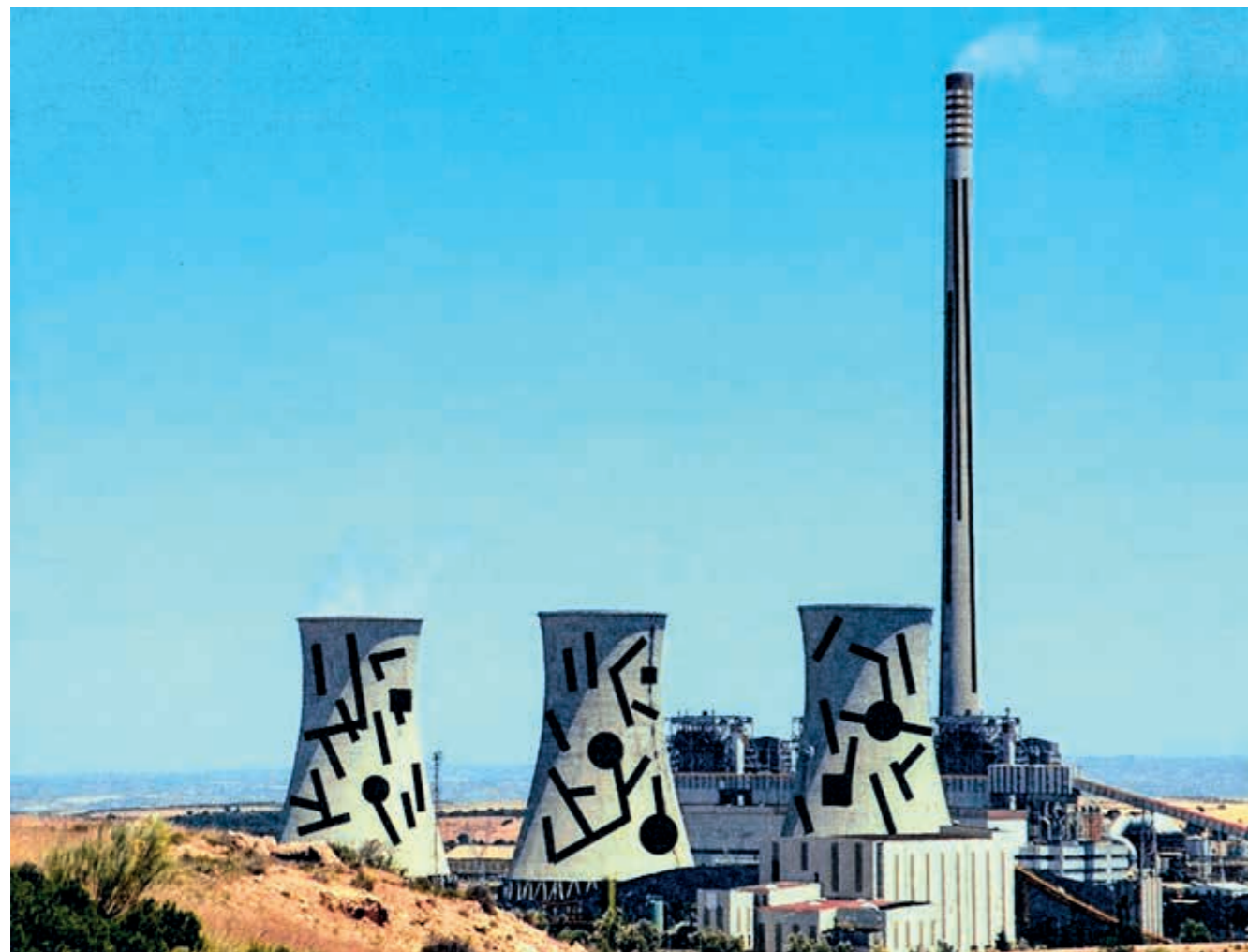
Vista general de la central térmica con la propuesta de intervención artística sobre las torres de refrigeración y la chimenea (archivo Miguel Ángel Arrudi).
