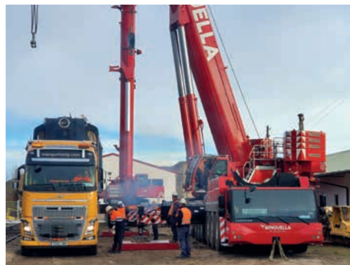
Dos grúas de gran tamaño fueron necesarias para levantar la locomotora.
